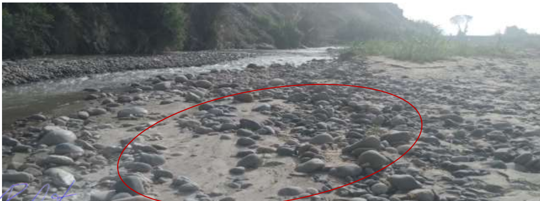
FIGURA N°02: , PROG. 6+100 - EXISTE OBRAS PROVISIONALES QUE ESTRECHA EL RÍO Y ESTA VULNERABLE LA MARGEN IZQUIERDA DEL RÍO.
