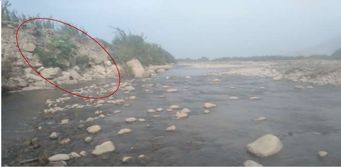
FIGURA N°01: , PROG. 5+600 - DIQUE EROSIONADOS Y TODO EL ANCHO DEL CAUCE SE ENCUENTRA COLMATADO Y ESTAN VULNERABLES AMBAS MARGENES DEL RÍO.
