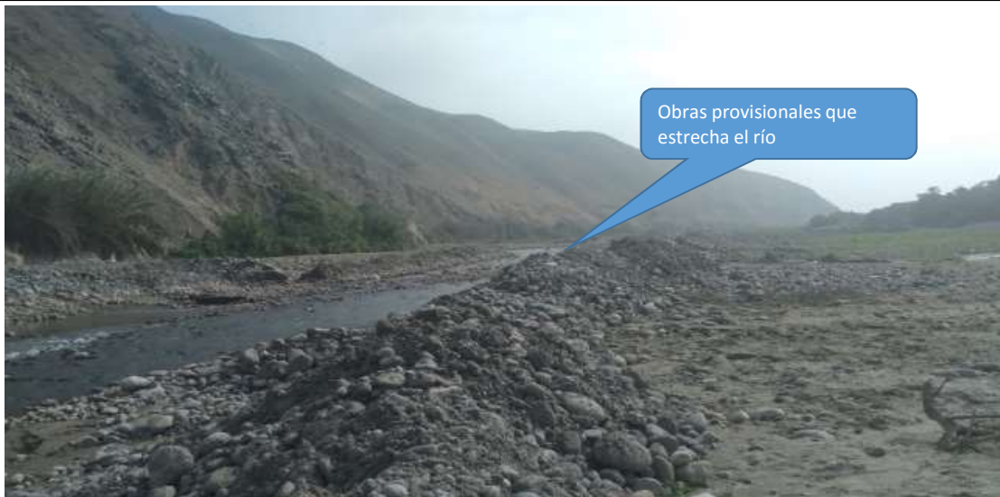
FIGURA N°02: , PROG. 6+100 - EXISTE OBRAS PROVISIONALES QUE ESTRECHA EL RÍO Y ESTA VULNERABLE LA MARGEN IZQUIERDA DEL RÍO.
